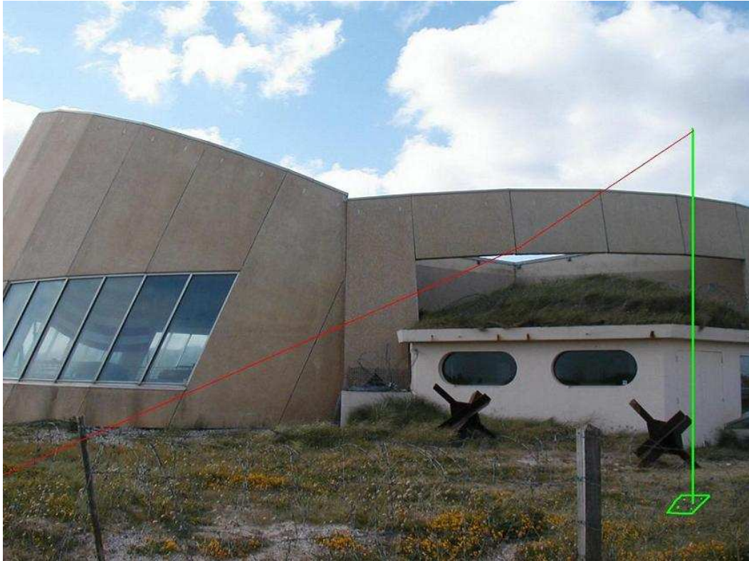
Mât avec dipôle en slooper
